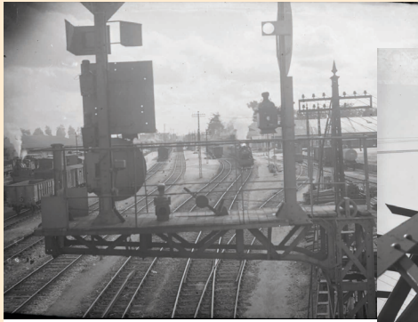
Vue panoramique sur la gare d'Alençon, 18 septembre 1930.
