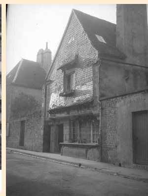
Alençon, maison dite à l'Étal (XV e siècle), au n° 10 de la rue Porte-de-la-Barre, vers 1930.
